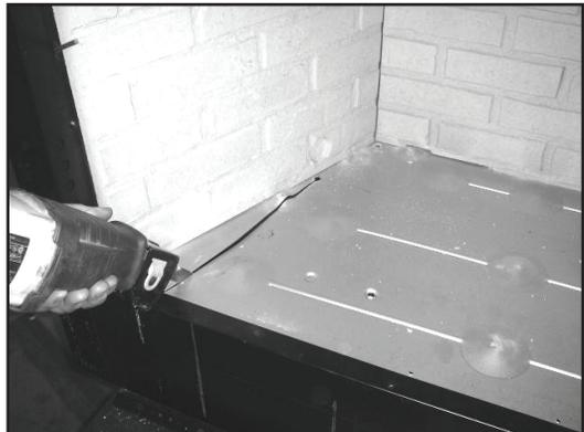
Figure 11.3. Découpez le fond en utilisant une scie à mouvement alternatif.
