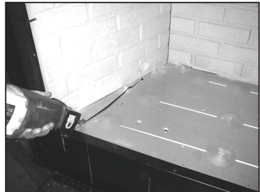
Figure 10.3 Découpez le fond en utilisant une scie alternative.
