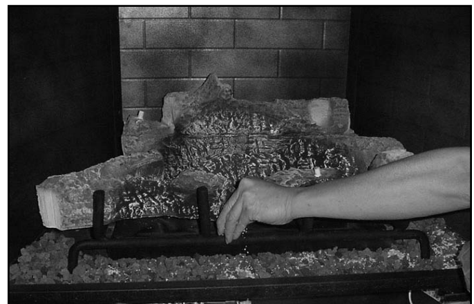
Figura 12.3 Colocación de la vermiculita
