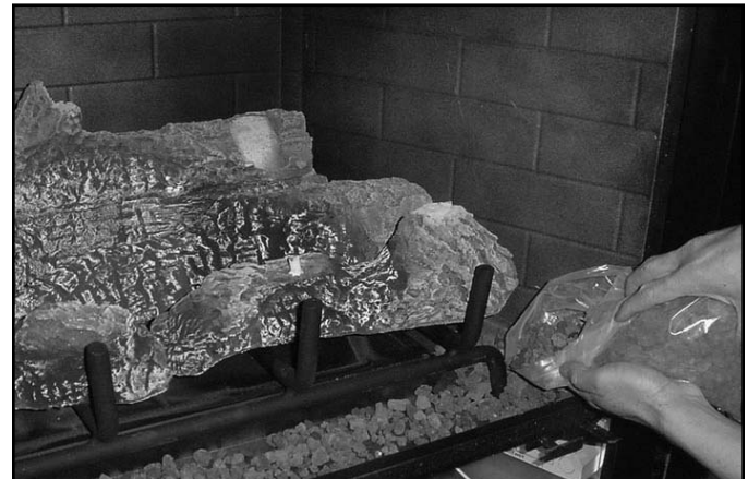
Figura 12.2 Colocación de la roca volcánica
