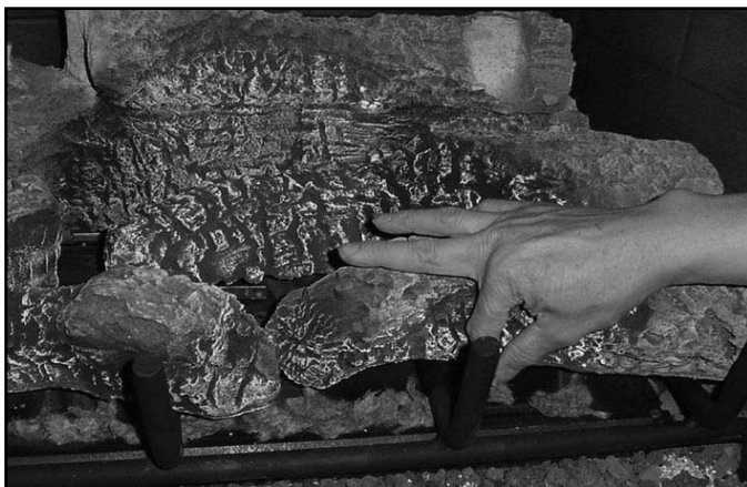
Figure 12.4 Placement de la laine minérale
