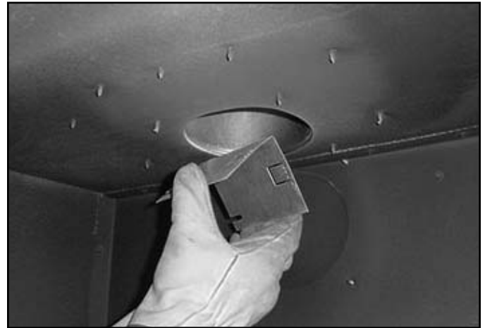
Figura 5.19 Colocación del deflector
