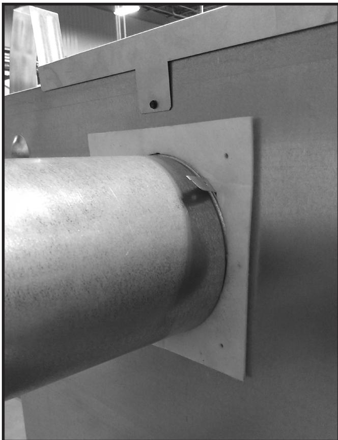
**Figure 6.11 (représentation d'un foyer générique)** Posez la première section du conduit d'évacuation (elle s'insérera en place avec un claquement). Glissez le joint d'isolation (expédié dans le sac du manuel) sur cette section du conduit, contre l'appareil, en passant sur les languettes.
