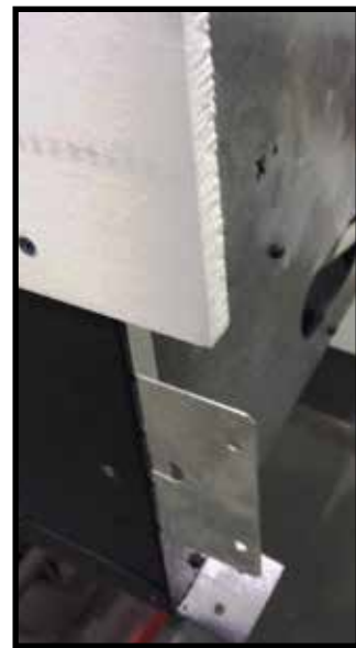
Figure 6.4 Languettes à clouer Position de l'installation
