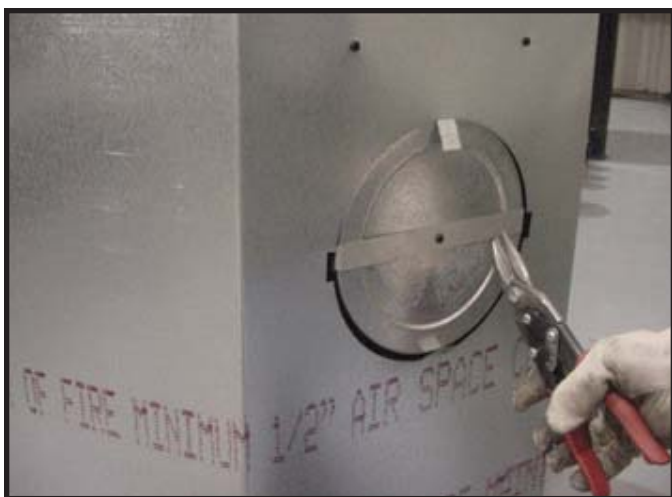
Figure 9.8 Coupez la bande de retenue de métal et repliez les côtés vers l'extérieur.
