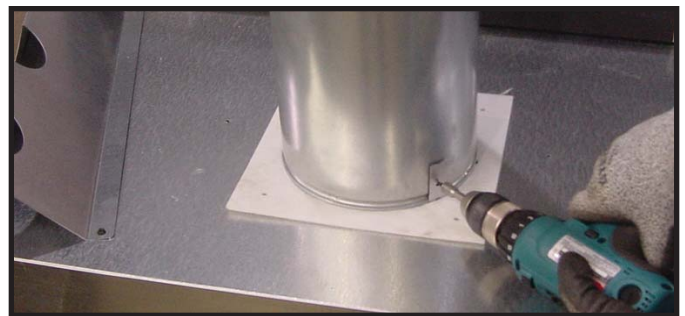
Figure 9.6 Pour attacher la première section du tuyau d'évacuation, assurez-vous d'utiliser le joint en fibre de verre expédié dans la pochette du manuel pour sceller le premier tuyau à l'enveloppe extérieure du foyer. Utilisez 2 vis autotaraudeuses pour attacher le joint à l'enveloppe extérieure.
