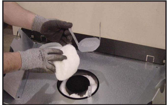
Figure 9.4 Jetez le panier isolant et l'isolant blanc du centre de tuyau du conduit.
