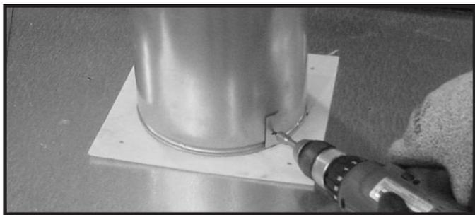
**Figure 6.6 (représentation d'un foyer générique)** Pour fixer la première section du conduit d'évacuation, assurez-vous d'utiliser le joint d'étanchéité en fibre de verre se trouvant dans le sac du manuel, pour sceller entre le premier composant et l'enveloppe extérieure du foyer. Utilisez 2 vis autotaraudeuses pour fixer le joint d'étanchéité à l'enveloppe extérieure.
