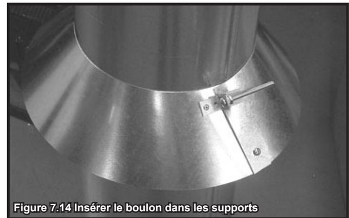
**Figure 7.14 Insérer le boulon dans les supports**
