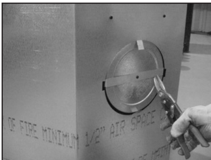
Figure 6.7 (représentation d'un foyer générique) Coupez la bande métallique de retenue et pliez les deux parties coupées vers l'extérieur.
