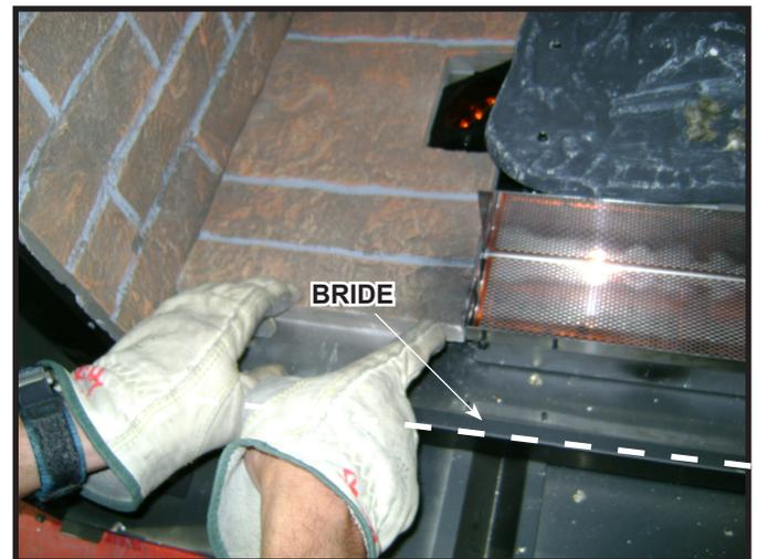
Figure 11.17 Positionnement du réfractaire sur la base au milieu à gauche et à droite
