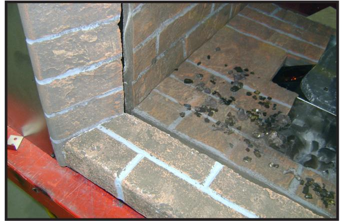
Figure 11.27 Installation de l'âtre extérieur
