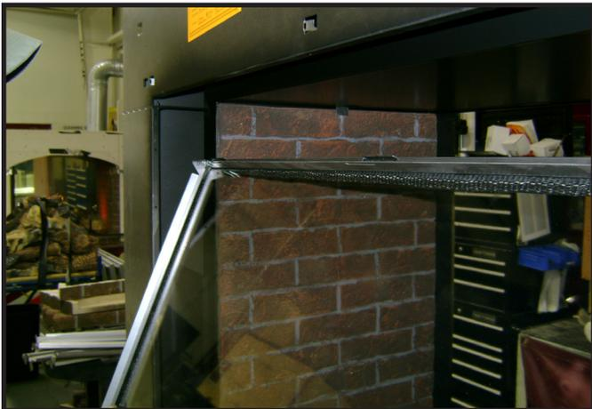
Figure 11.2 Position initiale du cadre dans l'ouverture.
