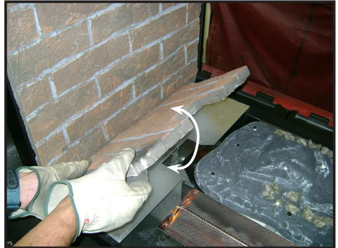
Figure 11.16 Positionnement du réfractaire intérieur inférieur
