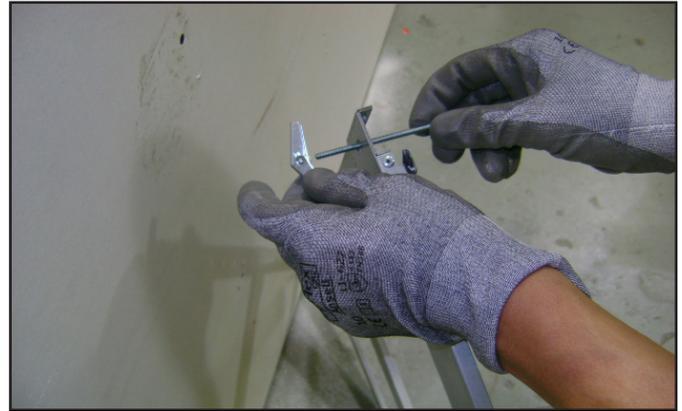
Figure 4.10 Installation des boulons à ailettes dans le support de fixation
