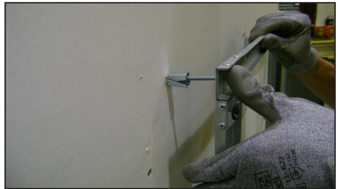
Figure 4.11 Installation des ancrages dans une cloison creuse
