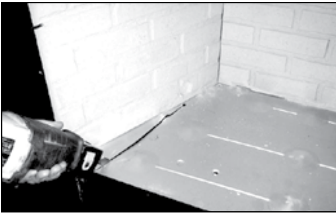
Figure 12.1 - Avec une scie sauteuse, découpez le plancher.
