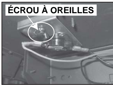
Figure 8.22 Glissez l'assemblage de thermostat/support sur les vis 10-32 situées en dessous de l'appareil. Fixez l'assemblage de support avec l'écrou à oreilles fourni.
