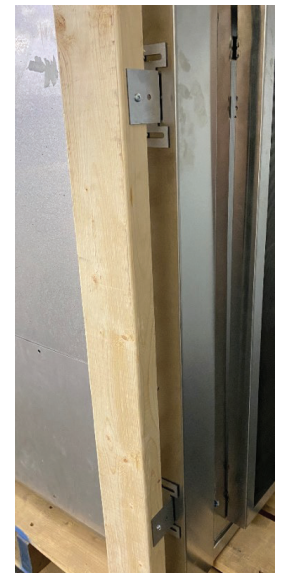
Figure 6.8 Fixation des supports d'installation à la charpente murale
