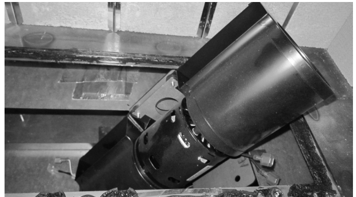
Figure 4.14 Retirez le ventilateur du trou d'accès.
