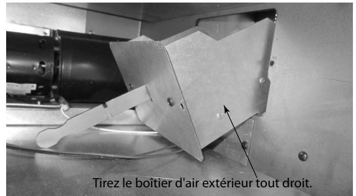
Figure 3.17 Boîte d'air extérieur
