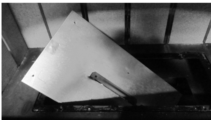
Figure 4.12 Retrait du couvercle de combustion
