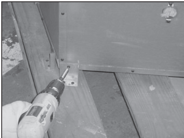
Figure 3.6 Retrait des supports d'expédition
