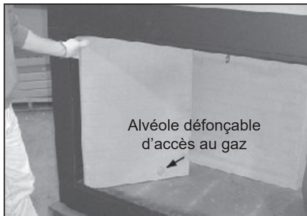
Figure 8.5 Installation de la brique réfractaire latérale
