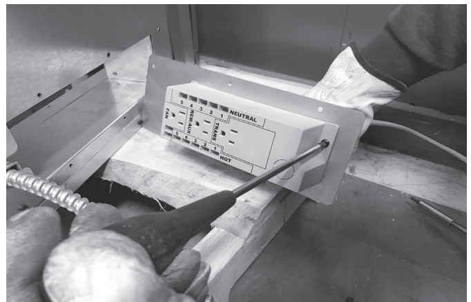
Figure 8.6 Démontage de la boîte de jonction
