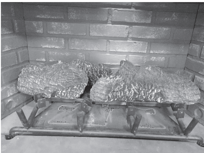
Figure 14.8 Positionnement des bûches à l'arrière gauche et à l'arrière droit
