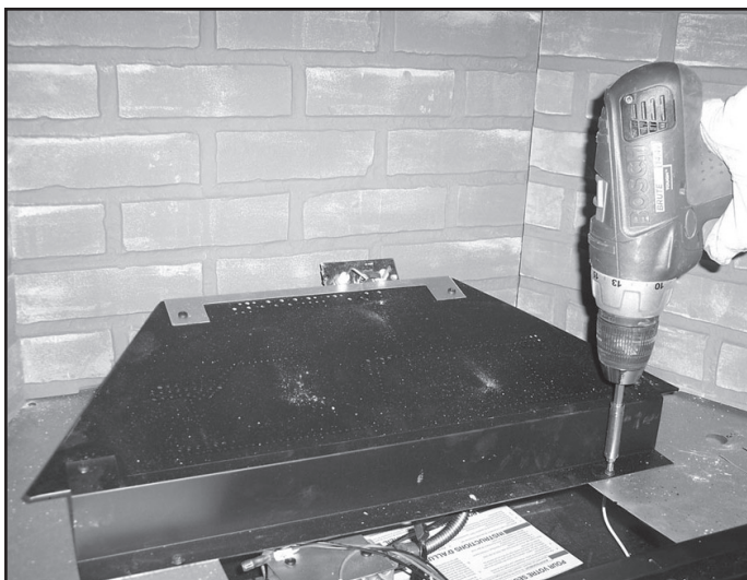
Figure 14.28 Retirez les vis fixant le support du brûleur avant
