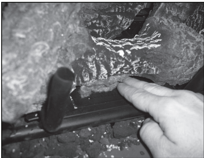
Figure 14.24 Mise en place de la laine de roche sous les bûches avant
