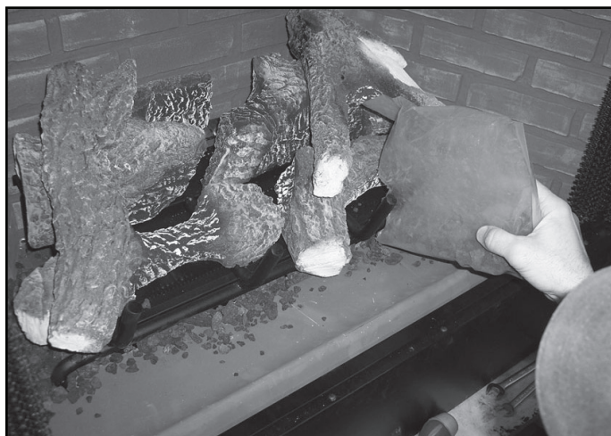
Figure 14.21 Disposition des pierres de lave
