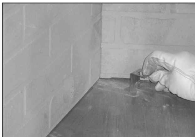
Figure 8.7 Faites glisser le support de fixation pour grille dans l'encoche
