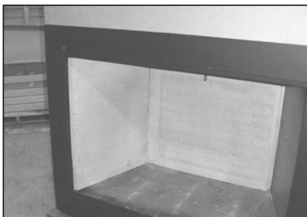
Figure 8.6 Brique réfractaire latérale installée
