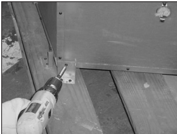
Figure 3.6 Retrait des supports d'expédition
