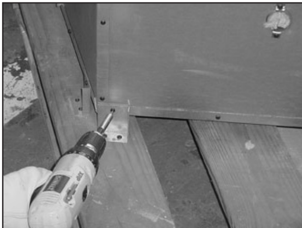
Figure 3.6 Retrait des supports d'expédition
