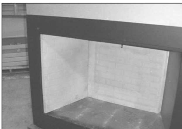
Figure 8.6 Brique réfractaire latérale installée
