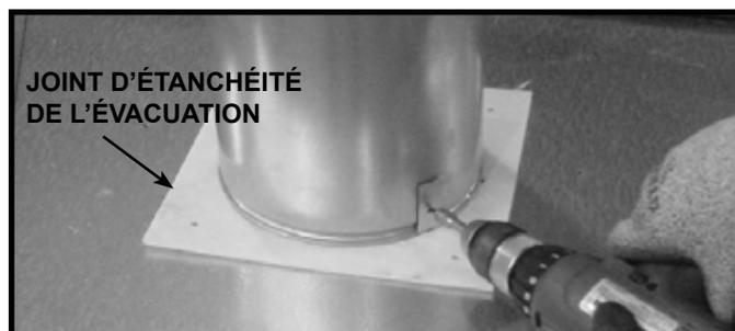
**Figure 6.11 (représentation d'un foyer générique)** Pour fixer la première section du conduit d'évacuation, assurez-vous d'utiliser le joint d'étanchéité de l'évacuation se trouvant dans le sac du manuel, pour sceller entre le premier composant et l'enveloppe extérieure du foyer. Vous pouvez sceller à l'aide de quatre vis ou d'un produit de calfeutrage ayant un indice d'exposition continue d'au moins 150 °C (300 °F) pour maintenir la pièce en place.
