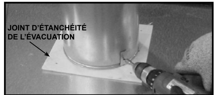
**Figure 6.6 (représentation d'un foyer générique)** Pour fixer la première section du conduit d'évacuation, assurez-vous d'utiliser le joint d'étanchéité de l'évacuation se trouvant dans le sac du manuel, pour sceller entre le premier composant et l'enveloppe extérieure du foyer. Vous pouvez sceller à l'aide de quatre vis ou d'un produit de calfeutrage ayant un indice d'exposition continue d'au moins 150 °C (300 °F) pour maintenir la pièce en place.
