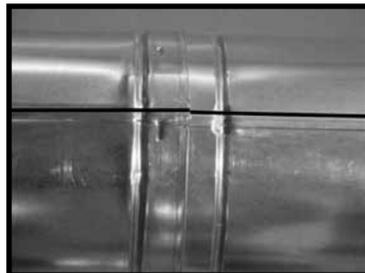
Figure 7.4 Joints d'assemblage **INCORRECT**
