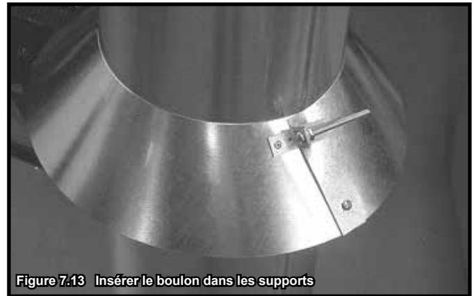
Figure 7.13 Insérer le boulon dans les supports
