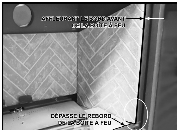
Figure 11.4 Panneau réfractaire latéral installé (côté droit illustré)
