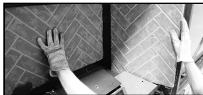
Figure 11.3 Installation du panneau réfractaire latéral (côté droit illustré)
