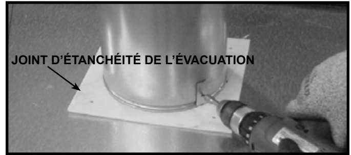
Figure 6.3 (représentation d'un foyer générique) Pour fixer la première section du conduit d'évacuation, assurez-vous d'utiliser le joint d'étanchéité de l'évacuation se trouvant dans le sac du manuel, pour sceller entre le premier composant et l'enveloppe extérieure du foyer. Vous pouvez sceller à l'aide de quatre vis ou d'un produit de calfeutrage ayant un indice d'exposition continue d'au moins 150 °C (300 °F) pour maintenir la pièce en place.
