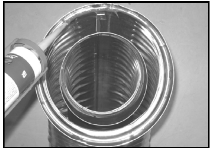
Figure 7.1 Scellant de silicone à haute température
