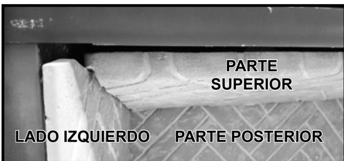
Figura 11.5 Instalación del panel refractario lateral - Se muestra el lado izquierdo
