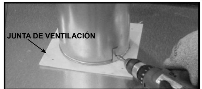
**Figura 6.6 (Se muestra un hogar genérico)** Para conectar la primera sección de la tubería de ventilación, asegúrese de utilizar la junta de ventilación que viene en la bolsa del manual para sellar el primer componente de ventilación y el recubrimiento exterior del hogar. Se puede utilizar un sellado con cuatro tornillos o masilla con una clasificación mínima de exposición continua de 300 °F para mantener la pieza en su lugar.
