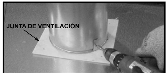
**Figura 6.11 (Se muestra un hogar genérico)** Para conectar la primera sección de la tubería de ventilación, asegúrese de utilizar la junta de ventilación que viene en la bolsa del manual para sellar el primer componente de ventilación y el recubrimiento exterior del hogar. Se puede utilizar un sellado con cuatro tornillos o masilla con una clasificación mínima de exposición continua de 300 °F para mantener la pieza en su lugar.
