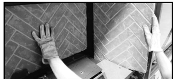
Figura 11.3 Instalación del panel refractario lateral (se muestra el lado derecho)
