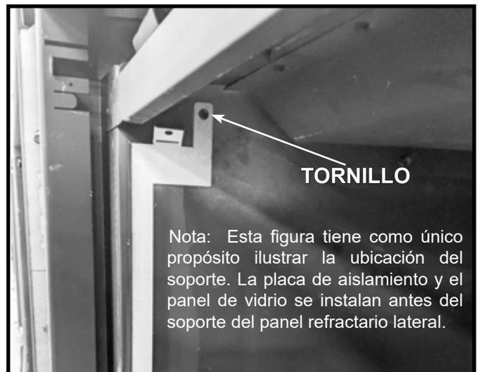
Figura 11.19 Soporte del panel refractario lateral en su posición
