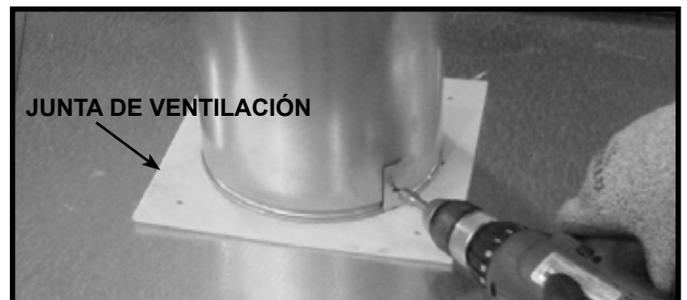
**Figura 6.11 (Se muestra un hogar genérico)** Para conectar la primera sección de la tubería de ventilación, asegúrese de utilizar la junta de ventilación que viene en la bolsa del manual para sellar el primer componente de ventilación y el recubrimiento exterior del hogar. Se puede utilizar un sellado con cuatro tornillos o masilla con una clasificación mínima de exposición continua de 300 °F para mantener la pieza en su lugar.
