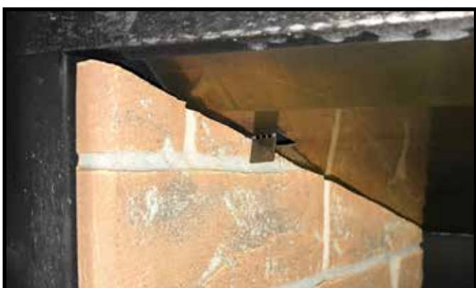
Figure 6 Languette de réfractaire gauche pliable à la main
