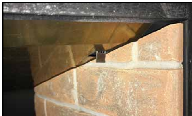
Figure 7 Languette de réfractaire droit pliable à la main
