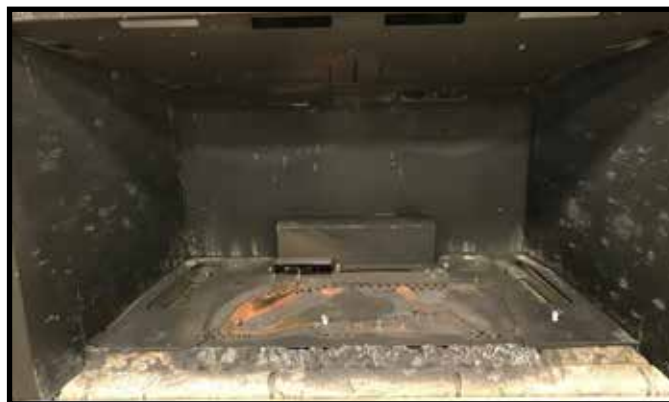
Figure 3 Réfractaire de base installé
