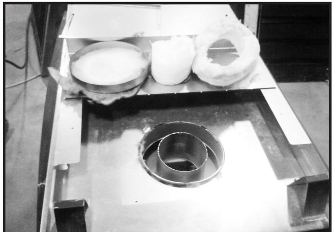
**Figure 6.5** Retirez et jetez le couvercle du conduit, l'anneau d'isolation, le bouchon d'isolation et le panier d'isolation. Fixez la première section d'évacuation (elle se cliquera en place). Glissez le joint du conduit d'évacuation sur cette section du conduit, puis verticalement contre l'appareil. Vissez le joint du conduit d'évacuation sur l'appareil avec deux vis autotaraudeuses présentes dans le sac du manuel. Remarque : Le joint du conduit d'évacuation se trouve dans le sac du manuel.
