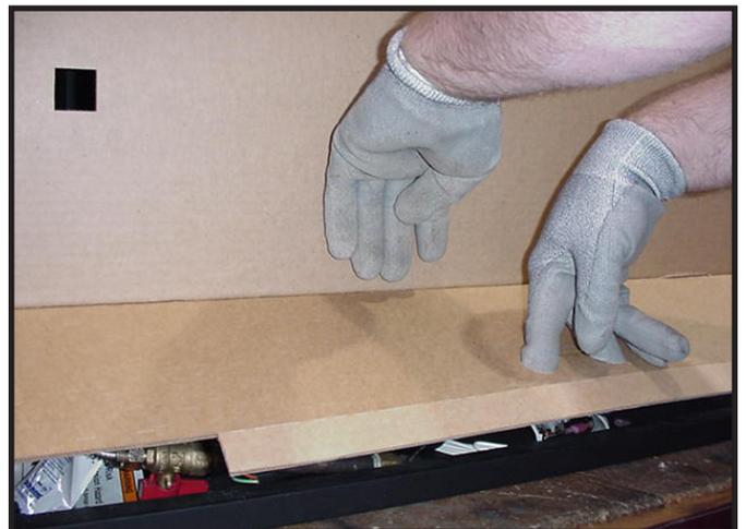
Figure 11.9 Ouverture d'un panneau d'accès inférieur
