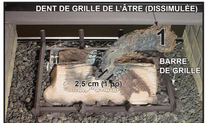
**ÉTAPE 2.** SIMILI-BÛCHE N° 1 (SRV2005-701) : Utilisez la dentelure au bas de la simili-bûche pour placer l'extrémité de grande taille de la simili-bûche sur la barre de la grille comme illustré. Glissez la bûche vers l'arrière jusqu'à ce que la dentelure s'engage dans la dent de la grille, comme montré ci-dessus. Placez l'extrémité étroite de la simili-bûche n° 1 à 2,5 cm (1 po) de la rampe d'orifices comme illustré.
