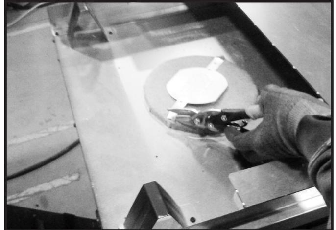
**Figure 6.3** Coupez la bande métallique de retenue et pliez les deux parties coupées vers l'extérieur.
