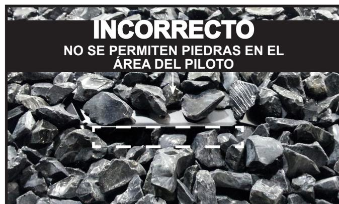
Figura 9.12 Colocación INCORRECTA de las piedras
