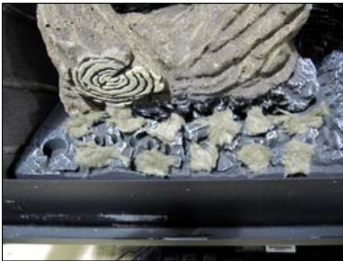
Figure 10.13 Placer la laine isolante
