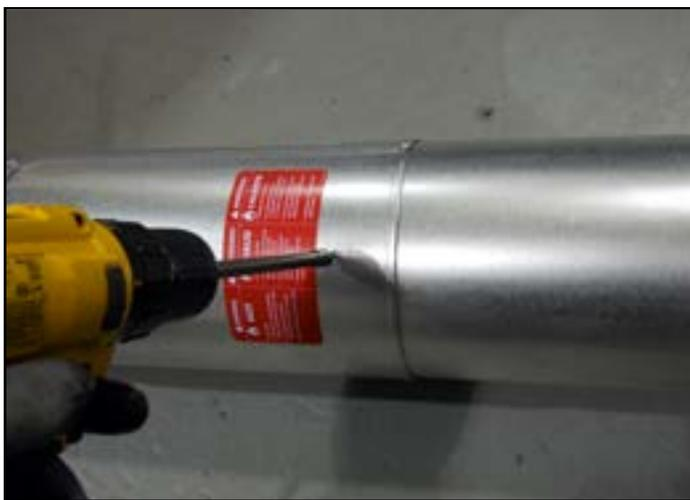
Figure 7.4 Vis de la section coulissante
