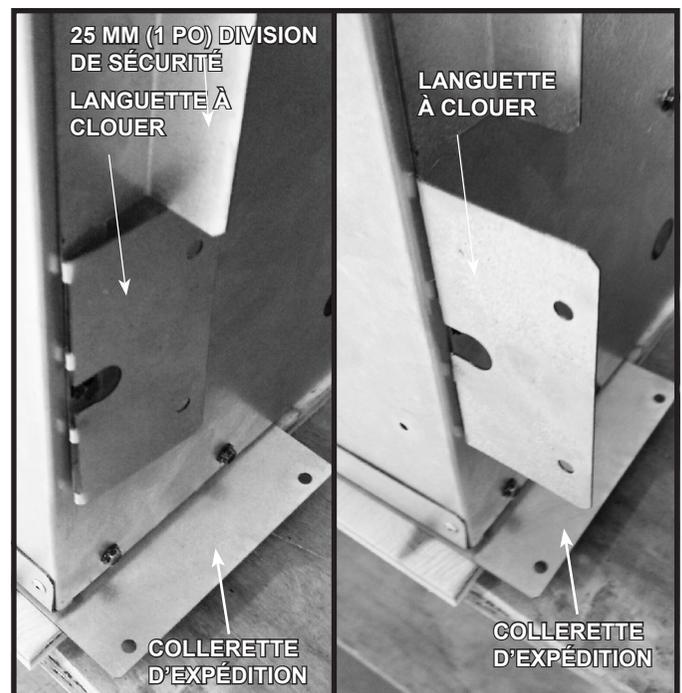
Figure 6.6 Languettes à clouer
