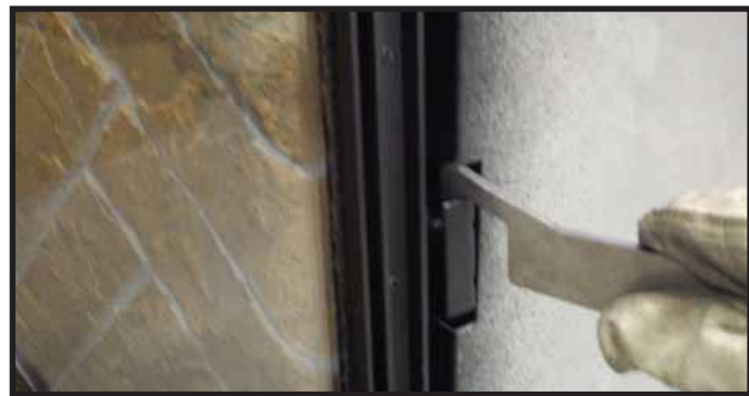
Figure 11.7. Sécuriser les clips de verre latéraux
