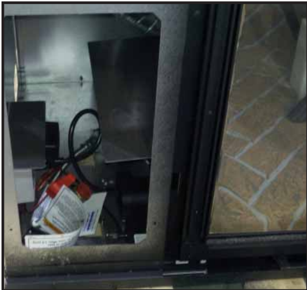
ACCÈS PAR LA COLONNE GAUCHE (Avant l'installation du panneau incombustible)
