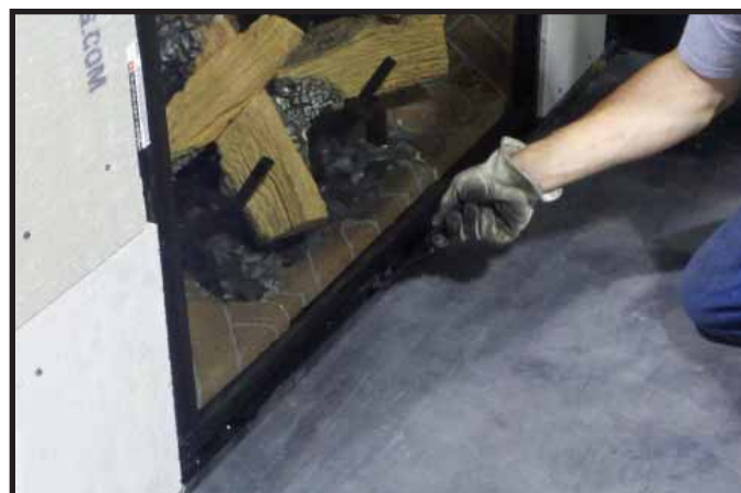
Figure 11.8. Sécuriser les clips de verre inférieurs
