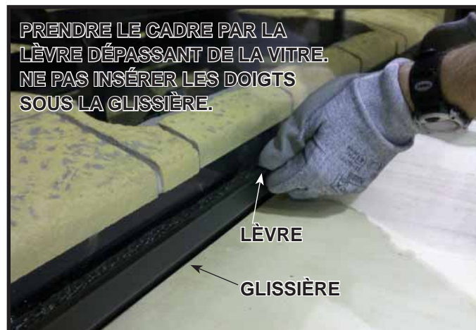
Figure 11.6. Installer la vitre
