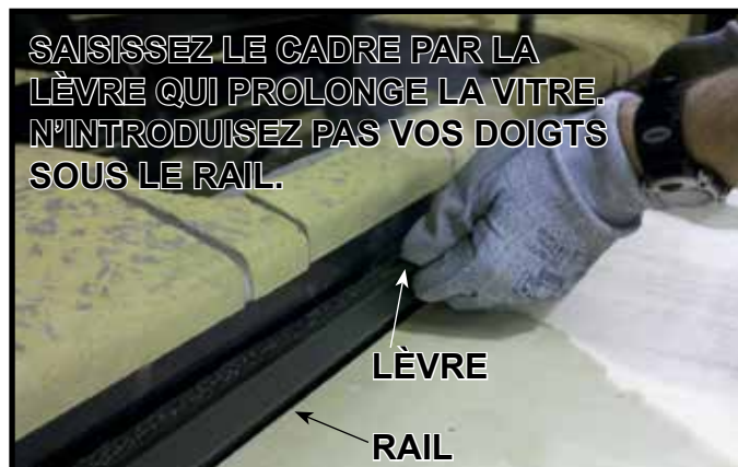
Figure 14.11. Installation de la vitre
