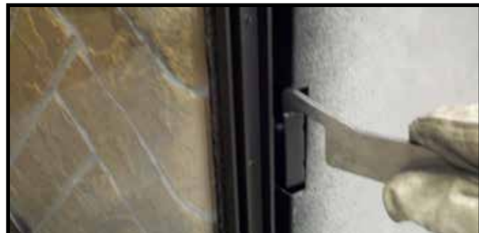
Figure 14.12. Arrimage des dispositifs latéraux de retenue de la vitre
