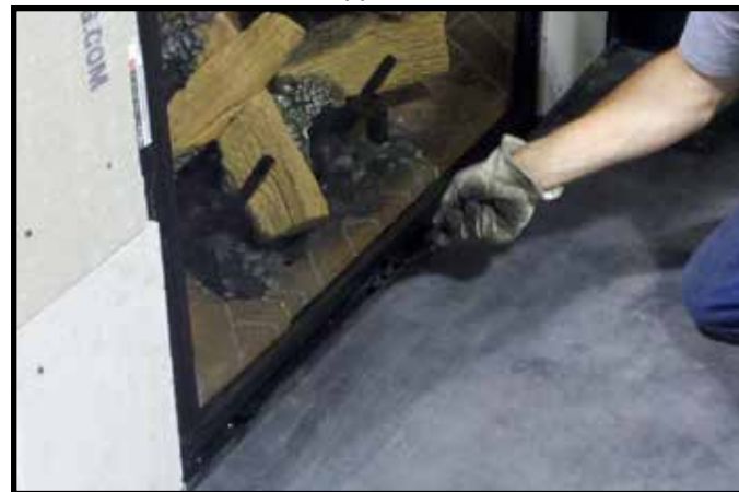
Figure 14.13. Arrimage des dispositifs inférieurs de retenue de la vitre
