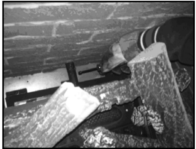
Figure 1. Emplacement de l'obturateur d'air
