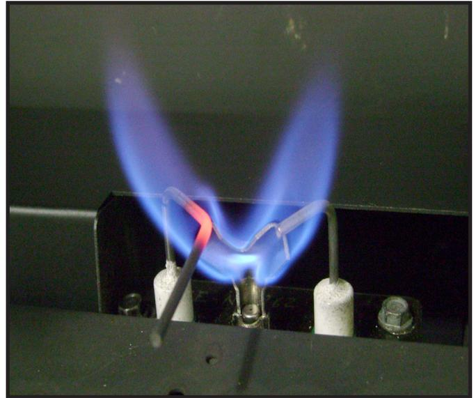
Figure 3.1 Modèles de flamme de veille IPI
