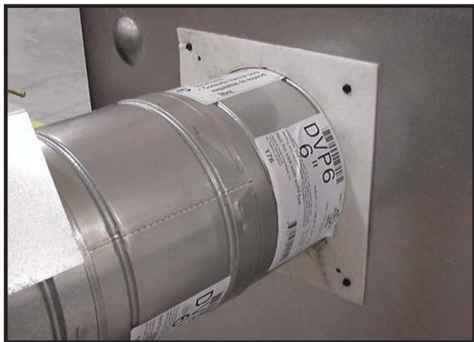
**Figure 9.16** Attacher la première section du conduit d'évacuation (celle-ci s'enclenchera). Glisser le joint isolant dans la section du conduit contre l'appareil et au-dessus des attaches. Utiliser deux vis autotaraudeuses pour attacher le joint à l'enveloppe extérieure.
