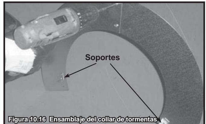
Figura 10.16 Ensamblaje del collar de tormentas
