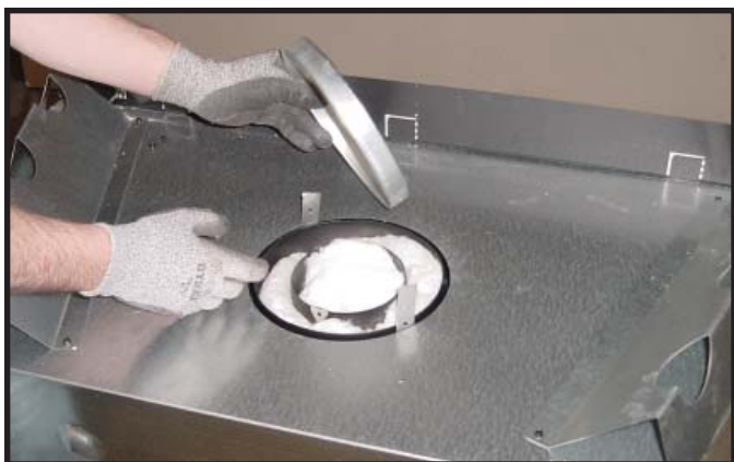
Figure 9.3 Retirez le capuchon plombé.
