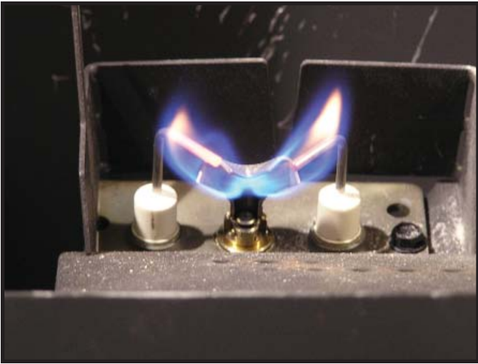
Figura 3.1 Apariencia de las llamas de un piloto IPI
