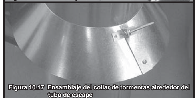
Figura 10.16 Ensamblaje del collar de tormentas
