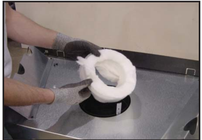
Figura 9.5 Retire el aislamiento que se encuentra dentro del tubo exterior. En el caso de una ventilación trasera el tubo exterior no tiene aislamiento.
