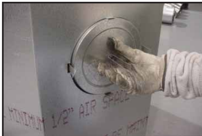
Figura 9.10 Jale la banda retenedora hacia afuera para así retirar la tapa selladora.
