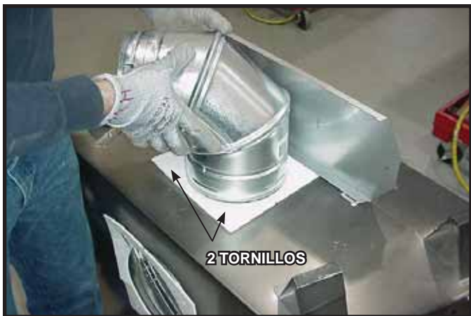
Figura 9.7 A la hora de instalar la primera sección del tubo, asegúrese de usar la empaquetadura de fibra de vidrio para sellar la abertura entre la primera sección de tubo y el envoltorio exterior de la chimenea. Utilice 2 tornillos autoperforadores para sujetar la empaquetadura.
