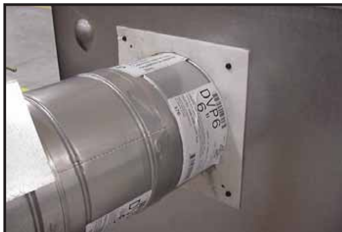
Figura 9.12 Una la primera sección de tubo a la chimenea. Coloque la empaquetadura alrededor del tubo y deslícela sobre las lengüetas hasta topar con la chimenea. Utilice 2 tornillos autoperforadores para sujetar la empaquetadura.
