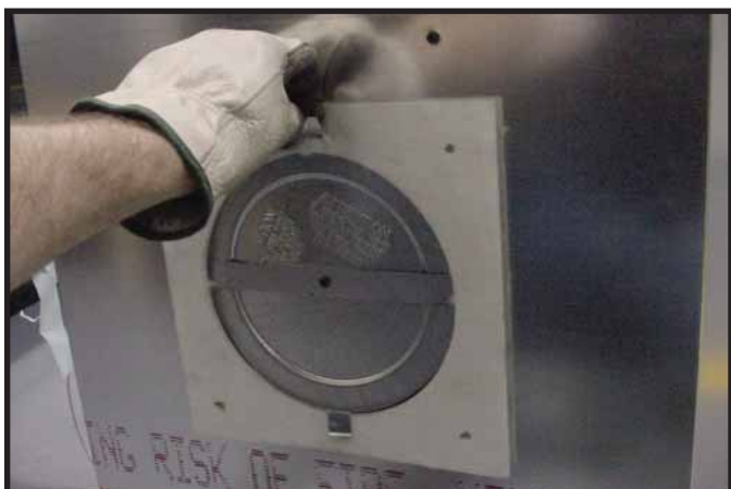
Figure 9.8 Plier les attaches du centre du tampon pare-feu (90°) vers l'intérieur et retirer le joint isolant.
