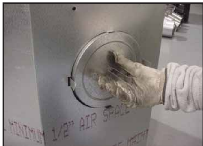
Figure 9.10 Plier vers le haut les parties centrales de la bande de retenue et les utiliser pour retirer le capuchon d'évent.
