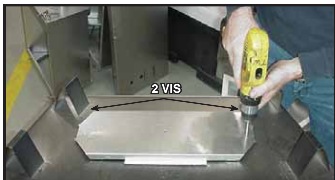
Figure 9.1 Pour l'évacuation par le dessus, enlevez les deux vis qui attachent l'écran de chaleur supérieur. Pour l'évacuation arrière, voir la section 9.B.
