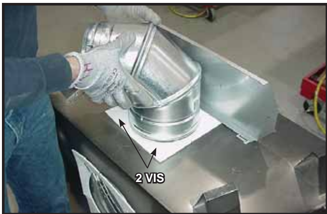
Figure 9.7 Pour attacher la première section du tuyau d'évacuation, utiliser le joint en fibre de verre pour sceller le premier composant du conduit à l'enveloppe extérieure du foyer. Utiliser 2 vis autotaraudeuses pour attacher le joint à l'enveloppe extérieure.
