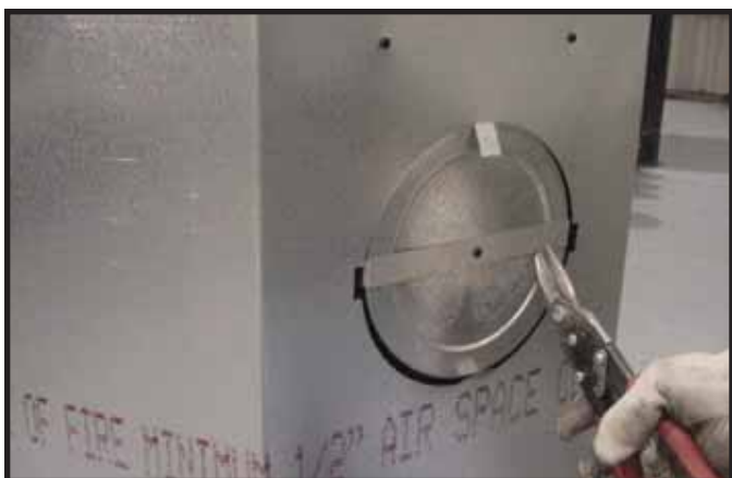
Figure 9.9 Coupez la bande de retenue en métal et pliez les bords vers l'extérieur.
