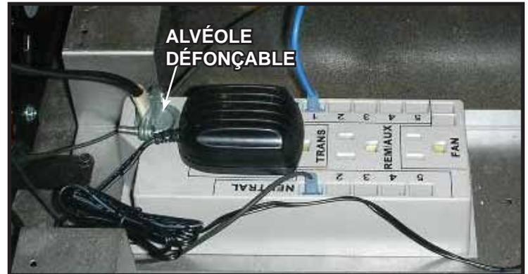
Figure 8.1 Détails de la boîte de jonction
