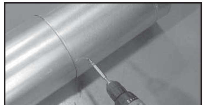
Figure 8.8 Vis dans la section de glissement
