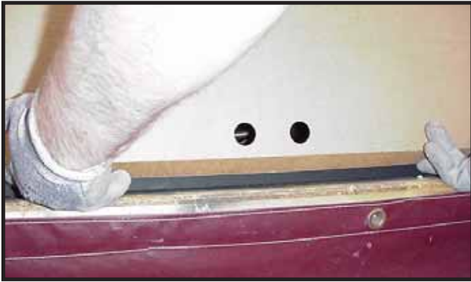
Figura 13.6 Doble parte inferior del protector de salpicaduras
