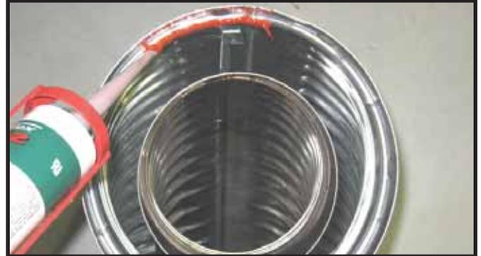
Figura 10.1 Silicona resistente a las altas temperaturas
