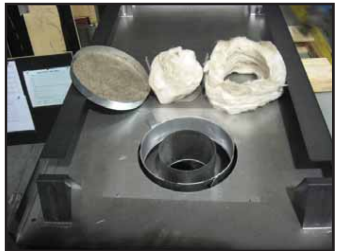
Figura 9.4 Retire y deseche la tapa selladora, el anillo de aislamiento, el tapón de aislamiento y el retenedor de aislamiento. Instale la primera sección de tubo a la chimenea. Coloque la empaquetadura alrededor del tubo y deslícela hasta topar con la chimenea. Asegure la empaquetadura a la chimenea usando los 2 tornillos autoperforadores que se encuentran en la bolsa que contiene el manual. Nota: La empaquetadura del tubo puede ser encontrada en la bolsa que contiene el manual.
