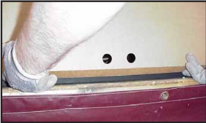
Figura 13.6 Doble parte inferior del protector de salpicaduras
