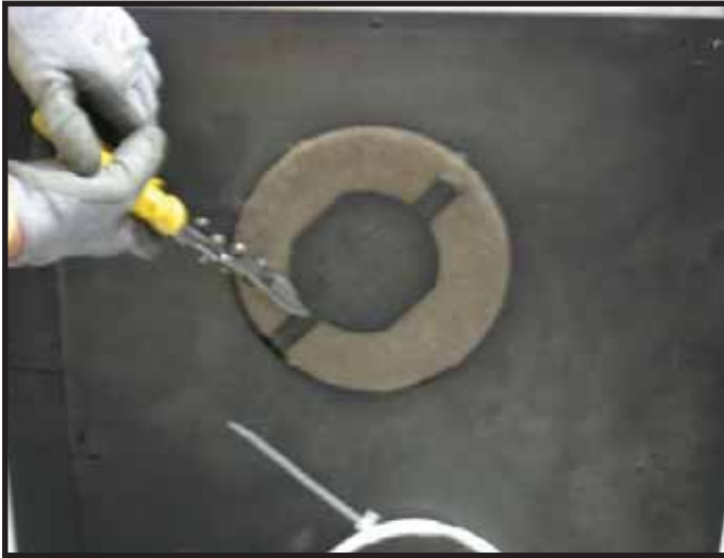
Figura 9.5 Corte la banda de retención.
