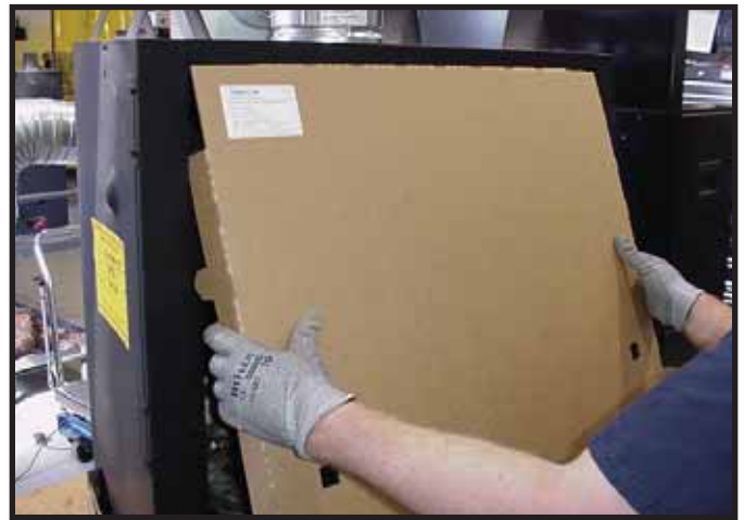
Figura 13.4 Instalación del protector de salpicaduras
